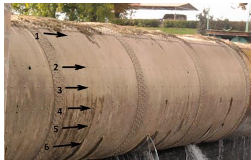
Rys. 3. Poziomy nit na powłoce walca
